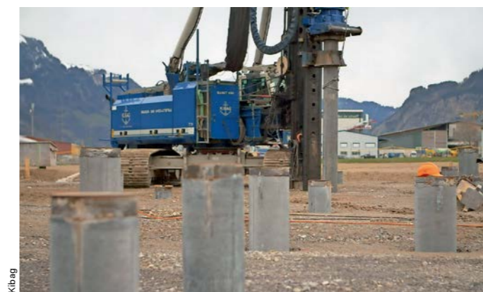
Energiepfahl-Feldtest in Eyschachen in der Schweiz.
